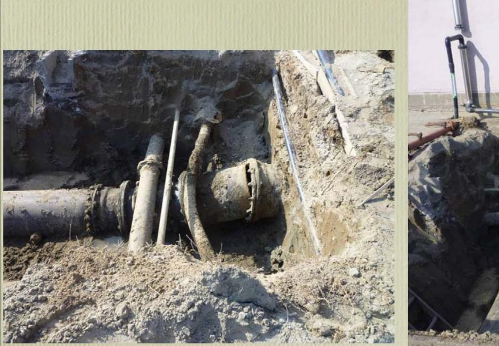
鹿行広域水道用水供給事業の取水棟への取り付け部の伸縮可とう管 φ600。周辺小口径管路が地盤と共に沈下したため、継手部で漏水
